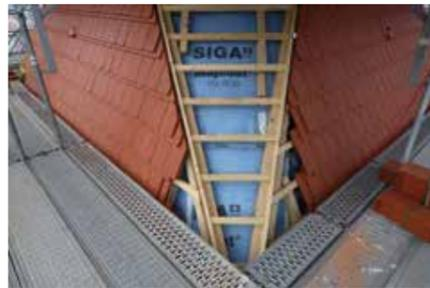
Das Turmdach mit verstärkter Lattung, Konterlattung, Unterspannbahn, Fledermaus-Dachziegeln und in typischer Biberschwanz-Eindeckung
