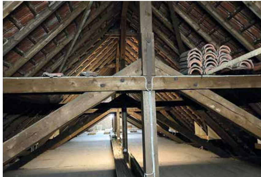
Links: Im kommenden Frühjahr soll die Kirche St. Franziskus eingerüstet werden und die Sanierungsarbeiten beginnen Oben: Dachstuhl über dem Kirchenschiff von St. Franziskus
