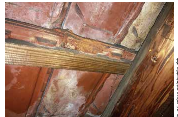
Stark verwitterte poröse Ziegelhaltenasen
